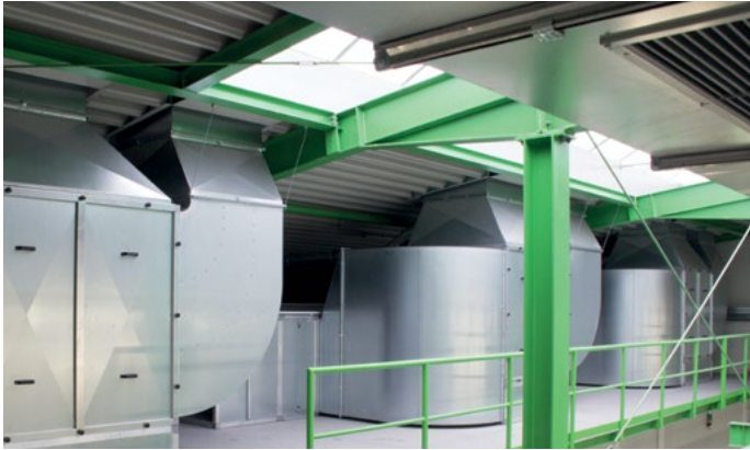
Ensemble combiné d'évacuation et d'alimentation d'air avec échangeur de chaleur à flux croisé.
