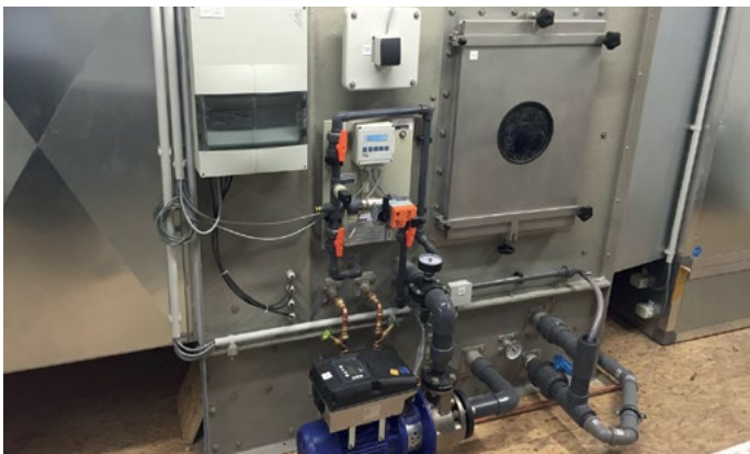
Humidificateur pour l'alimentation en air.
