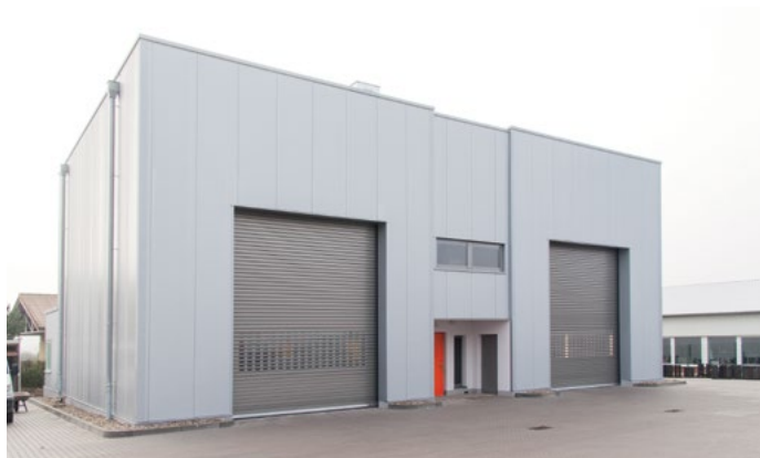
Centre pour la peinture de chariots de manutention lourds, avec cabine de lavage (ga.) et cabine de peinture (dr.)
