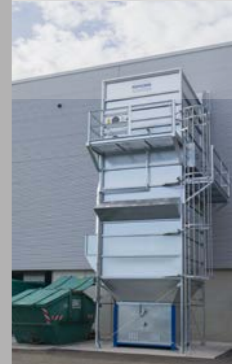
La poussière de papier peut être stockée facilement et en toute sécurité. La BrikStar C dans une imprimerie combinée avec un filtre MultiStar.
